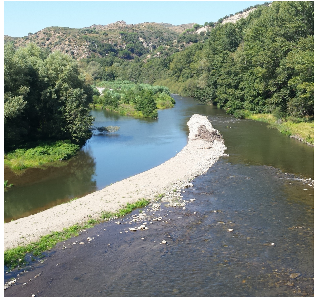
prise d'eau canal de Perpignan (à gauche)
